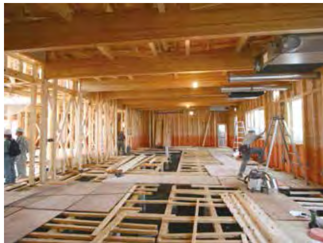
工事状況 9月24日
