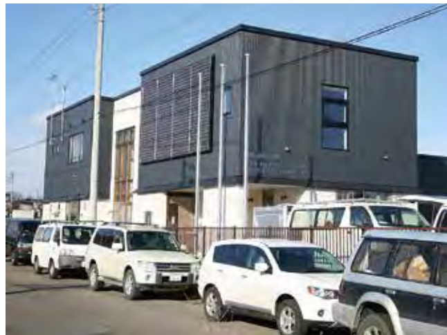
工事状況 12月4日
