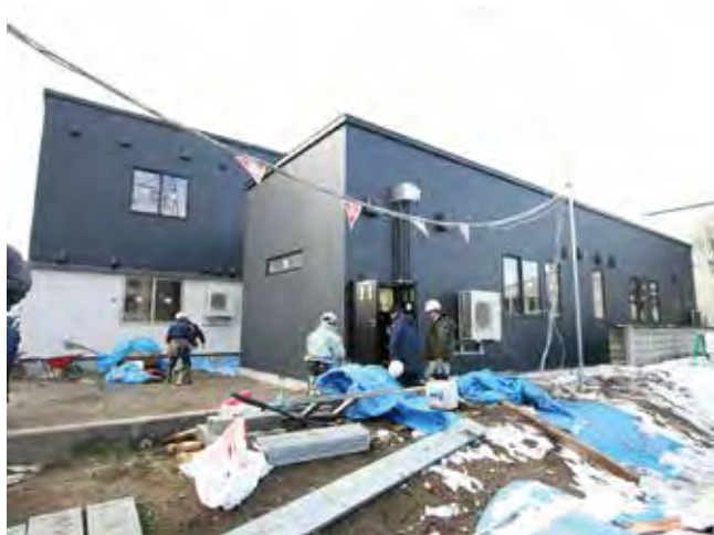
工事状況 11月19日
