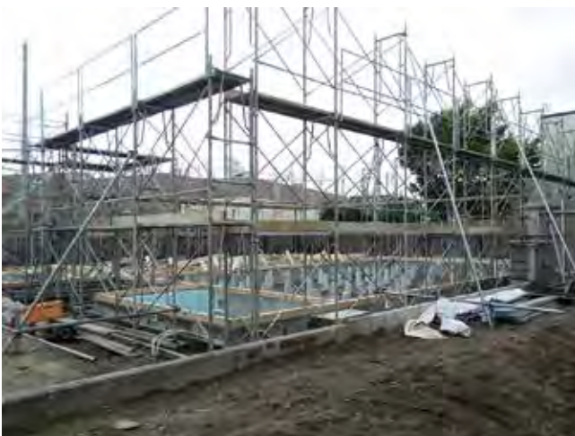
工事状況 8月20日
