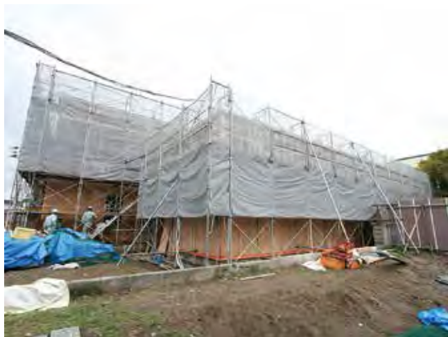
工事状況 9月10日
