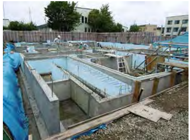
工事状況 8月6日
