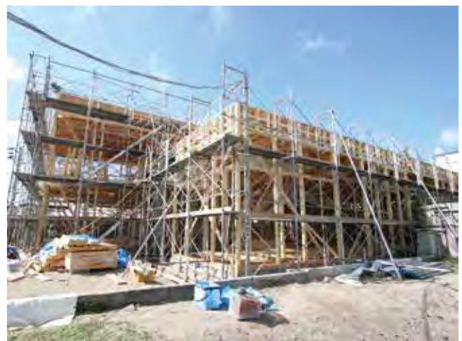
工事状況 9月3日
