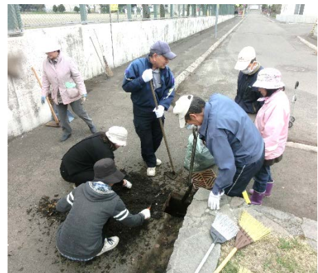
北野中学校前の 側溝と雨水柵の清掃
